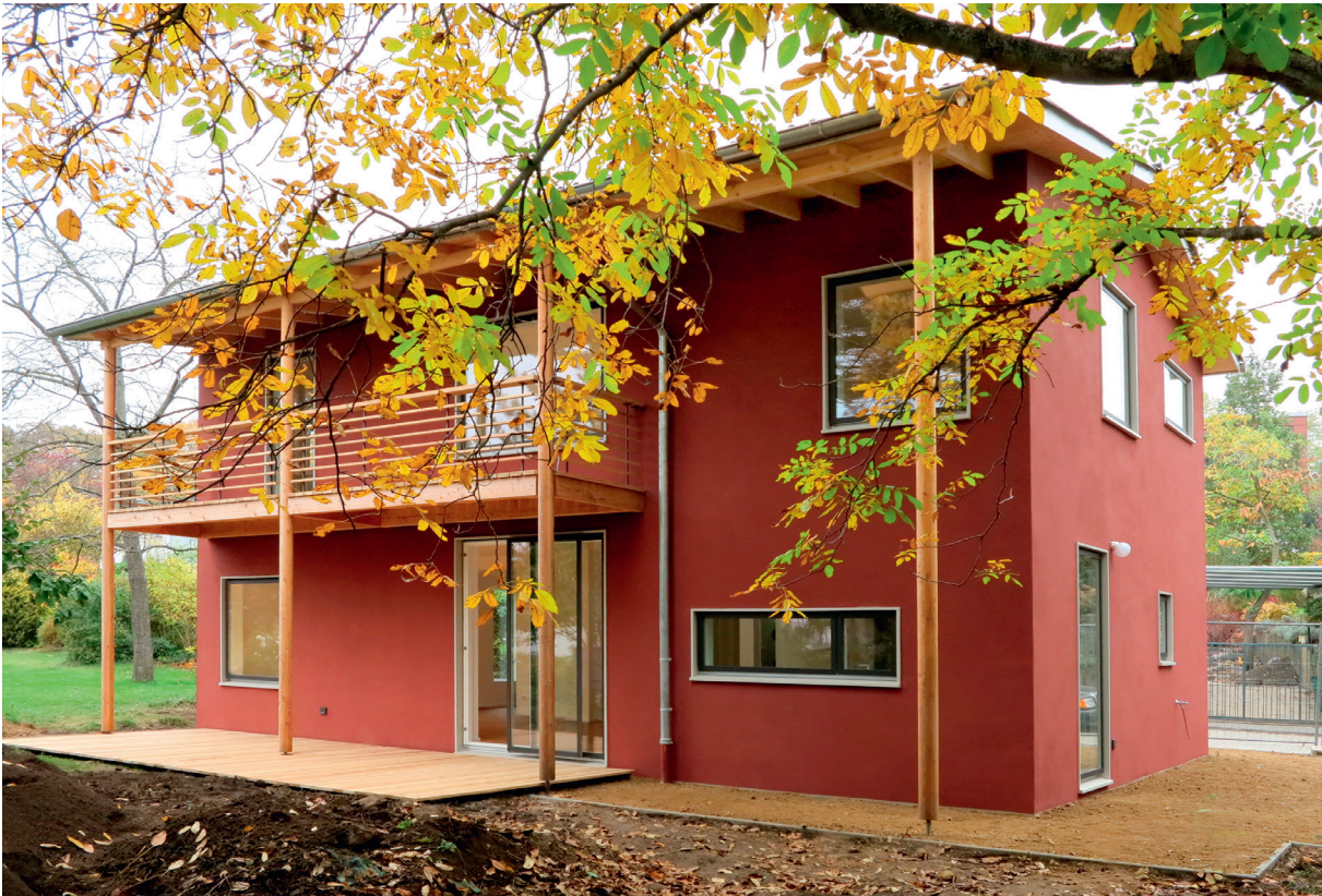
Abb. 3-8 Haus J, Darmstadt. 3: Nach 6 Monaten Bauzeit frisch fertiggestellt: Die Außenschale aus schwerem Strohleichtlehm ist mit Kalk verputzt. 4: Die außen das Haus umschließende durchgehende Lehmschale trocknet etwa 4 Wochen. 5: Holzbau und Leichtlehm auf Lattung, Lehmarbeiten im Schutz des gedeckten Daches 6: Aufbereitung trockenen Lehms mit einer Knauf PFT G4.
