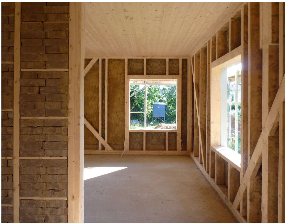
Abb. 8 Haus J, Rohbau von innen. In die Zwischenräume der Außenwand wird nach Trocknung Dämmstoff hinter die Innenbeplankung geblasen. Die Innenwände sind mit schweren Lehmsteinen ohne Mörtel ausgestapelt.
