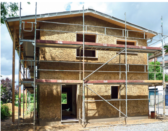
Abb. 3-8 Haus J, Darmstadt. 3: Nach 6 Monaten Bauzeit frisch fertiggestellt: Die Außenschale aus schwerem Strohleichtlehm ist mit Kalk verputzt. 4: Die außen das Haus umschließende durchgehende Lehmschale trocknet etwa 4 Wochen. 5: Holzbau und Leichtlehm auf Lattung, Lehmarbeiten im Schutz des gedeckten Daches 6: Aufbereitung trockenen Lehms mit einer Knauf PFT G4.
