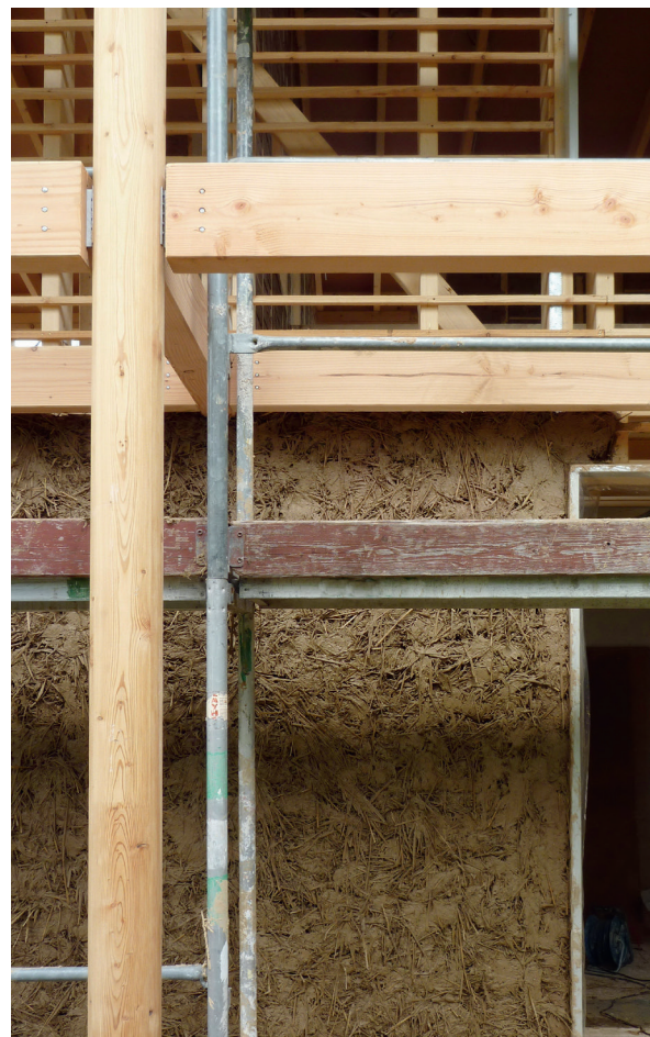
Abb. 3-8 Haus J, Darmstadt. 3: Nach 6 Monaten Bauzeit frisch fertiggestellt: Die Außenschale aus schwerem Strohleichtlehm ist mit Kalk verputzt. 4: Die außen das Haus umschließende durchgehende Lehmschale trocknet etwa 4 Wochen. 5: Holzbau und Leichtlehm auf Lattung, Lehmarbeiten im Schutz des gedeckten Daches 6: Aufbereitung trockenen Lehms mit einer Knauf PFT G4.
