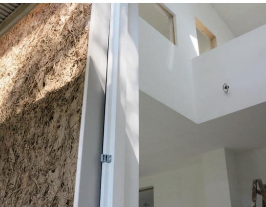
Nach der Trocknung des Leichtlehms wird dieser mit Kalk verputzt.
