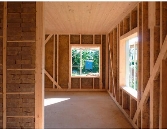
In die vorgefertigten Innenwände wurden schwere Lehmsteine trocken gestapelt.
