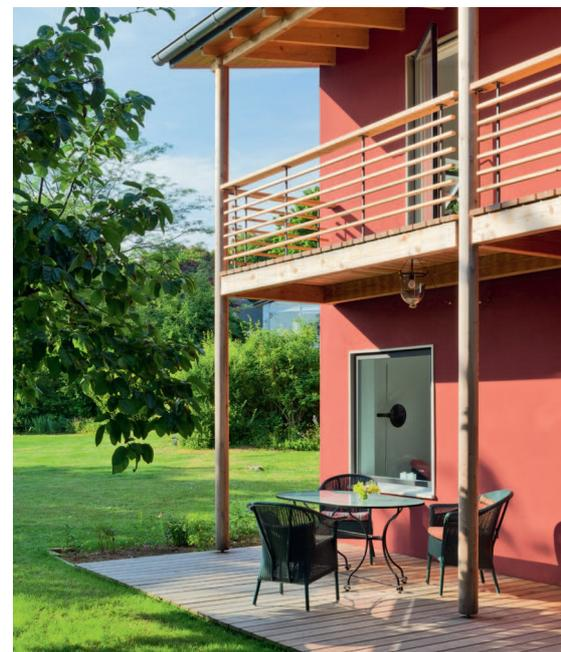
Luftdicht, diffusionsfähig und kapillaraktiv ist die Fassade aus Lehmschale, Kalkputz und Silikatfarbe. Der erdige Vollton der Fassade passt gut zum Wandaufbau.
