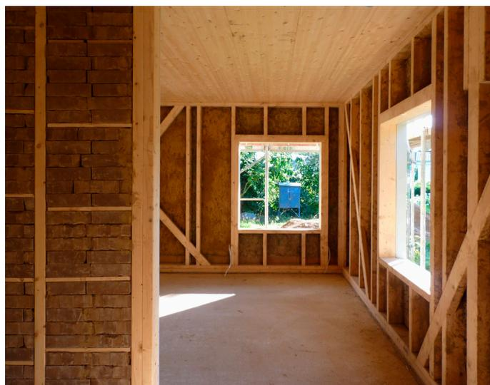
(10) Bei der Fachwerksanierung ist die homogene Ausmauerung der Gefache mit Leichtlehmsteinen Stand der Technik. Haus Schneiker, Mörfelden, Schauer+Völhard Architekten BDA
