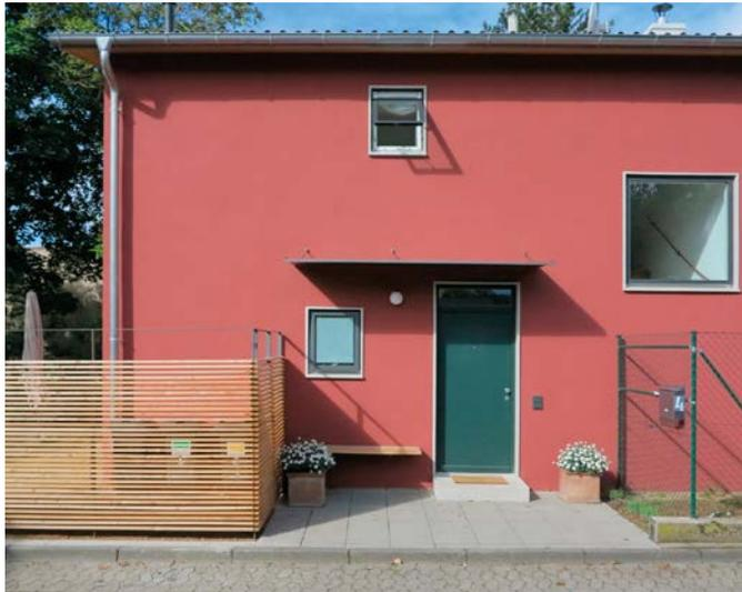
Bild 4: Das Haus J in Darmstadt; Holz-Lehm-Haus als elementierter Holzrahmenbau mit Innendämmung
