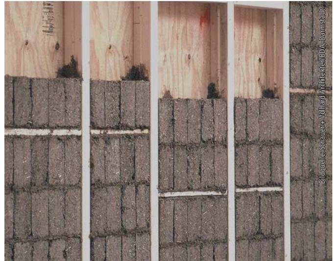
Bild 8: Ausfachung der Elemente mit gestapelten Lehmsteinen, Atelierhaus
