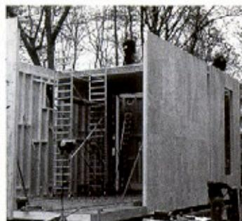
Für eine möglichst kurze Bauzeit wurden die mit Sperrholz beplankten Holzrahmenelemente für Bodenplatte, Wände und Dach größtenteils vorgefertigt.
