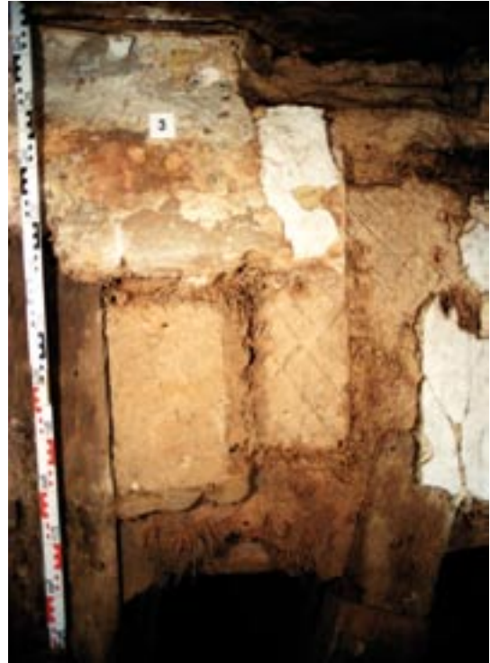
Abb. 1-4 Innenwand Gefach 3 (16. Jh.) vor Ausbau
