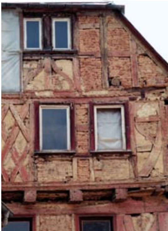
Abb. 1-1 Freigelegte Ostfassade, Gefach 2 vor Ausbau (linkes Brüstungsgfach Obergeschoss, spätere Lehmsteinmauerung anstelle früherer Kreuzstreben)
