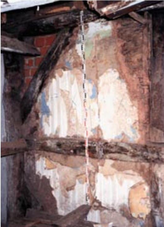
Abb. 1-3 Außenwand Gefach 1 (13. Jh.) vor Ausbau
