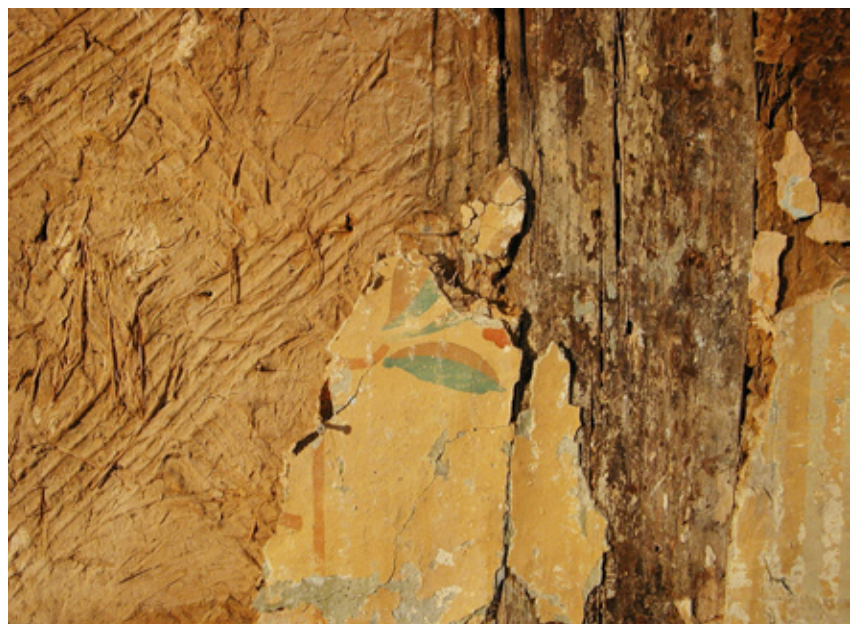
Abb.4 Lehmstuck mit Kalkfeinputz auf einem Deckenbalken, Römer 2-6, Limbug. Das Muster ist in den Lehm eingedrückt, die Oberflächendetails im ca. 8 bis 10mm starken Kalkputz modelliert. Foto: Klein, U., Freies Institut für Bauforschung und Dokumentation e.V., Marburg
