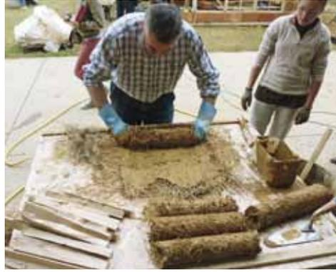
Abb. 157 Herstellung der Wickel auf dem Tisch
