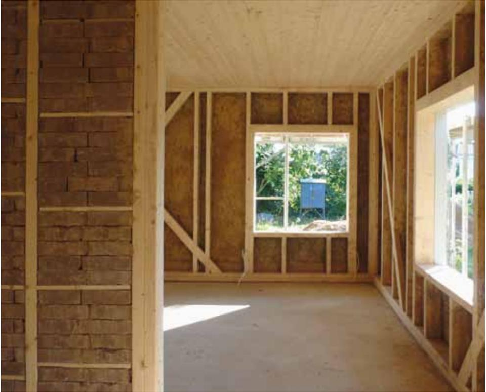
**Abb. 484** Außenwände 12cm Leichtlehm, Innenwände mit Lehmsteinen ausgestapelt
