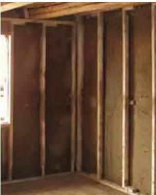
Abb. 429 Innenwandmauerwerk mit Leichtlehmsteinen
