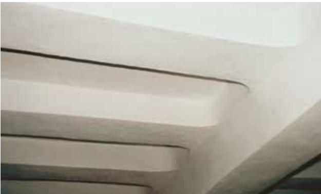
Abb. 161 Kalkverputzte Lehmdecke »Kölner Decke« (Breidenbach)
