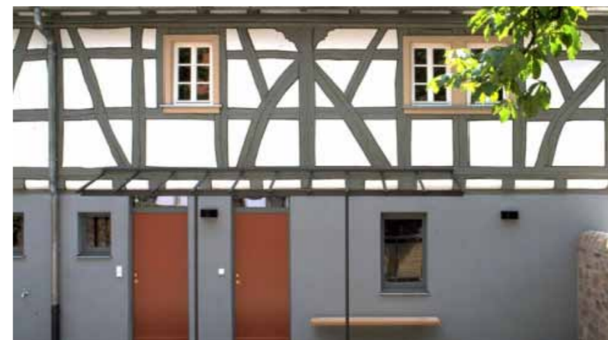
Abb. 17: Fachwerksanierung in Mörfelden, »Schneikerhaus«. Ausmauerung mit Leichtlehmsteinen, Innenschale Holzlehm in Lehm-Trockenbauplatte (Schauer + Volhard Architekten).
