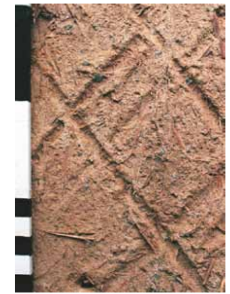
Abb. 7: Strohlehminnenputz, Gotisches Haus, Innenwand von 1583. Rautenstrich aktiviert die Feinfasern des Untergrundes für eine gute Kalkputzhaftung.
