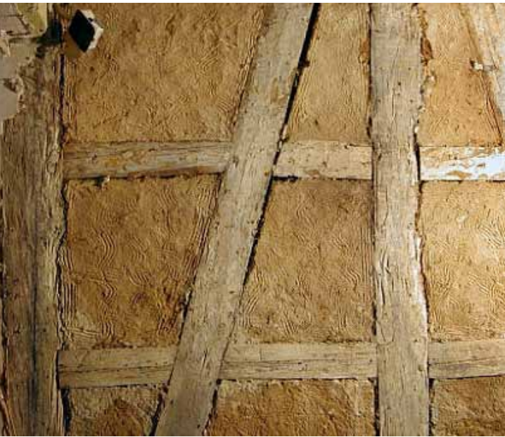
Abb. 1: Innenwand mit Strohlehmausfachungen guter Qualität. Darmstadt, Hofreite von 1756 (Projekt Sandberghof in Darmstadt).
