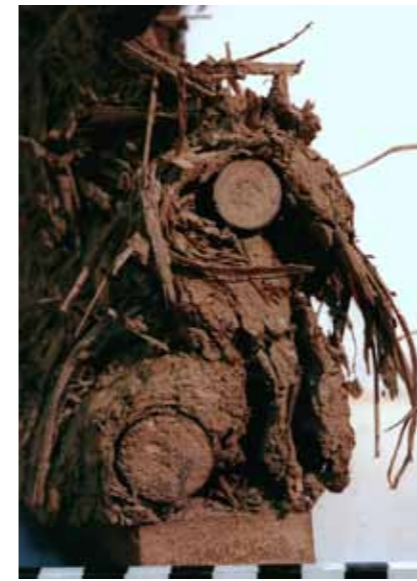
Abb. 5: Gotisches Haus, Innenwand von 1660, Erstauftrag. Der Strohlehm mit einer Trockendichte von 1400 kg/m 3 ist um die Ruten auf die andere Seite gewickelt.
