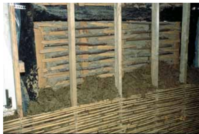
Abb. 13: Verbesserung der Wärmedämmung einer Fachwerkwand. Holzlehm-Innenschale, außen halber Strohhalmbewurf auf Flechtwerk, innen Schilfrohr als verlorene Schalung (Foto: claytec®, Ausführung Fa. Lehmhaus Peter Breidenbach, Viersen).
