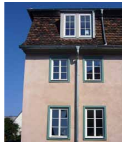
Abb. 16: Fachwerksanierung in Darmstadt, »Sandberghof«. Ausmauerung mit Leichtlehmsteinen, Innendämmung Zellulosefaser in Lehm-Trockenbauplatte (Schauer + Volhard Architekten).
