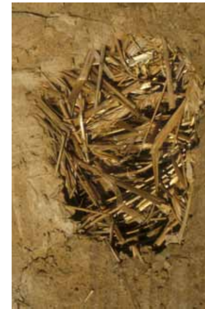
Abb. 6: Hohe Strohdichte eines Gefachlehms, Darmstadt, 18. Jahrhundert
