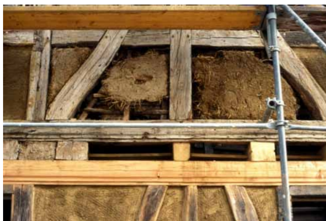
Abb. 12: Fachgerechte Reparatur von Strohhalmgefachen mit gleichem Material. Fachwerksanierung in Mörfelden, (Schauer + Volhard Architekten).
