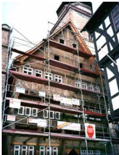
Abb. 14: Neuausfachung mit Strohhalmlehm, Alsfeld, Markt 2
