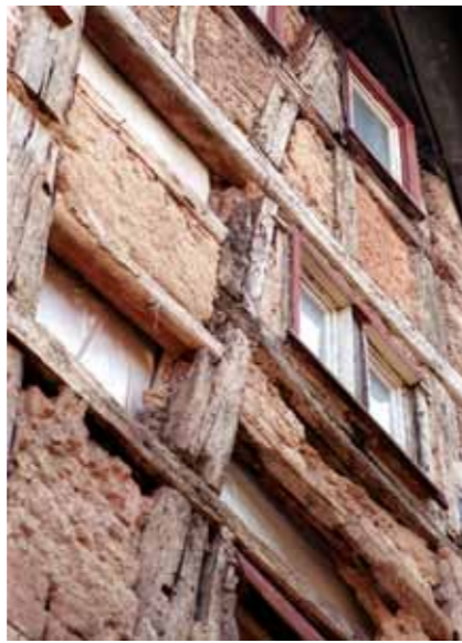
Abb. 3: Nordwand des Gotischen Hauses in Limburg vor dem Umbau
