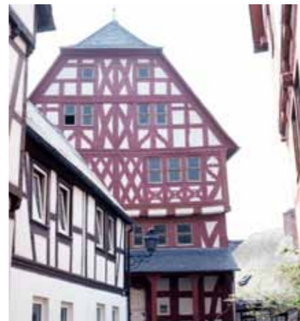
Abb. 15: Gotisches Haus in Limburg, Westfassade nach Fertigstellung des Umbaus und der Sanierung. Neuausfachungen mit Strohhalmlehm auf Flechtwerk, Leichtlehm-Innenschale, Dünnere Kalkputz auf gelochertem Strohhalmuntergrund (Foto: claytec®, Ausführung Fa. Lehmhaus Peter Breidenbach, Viersen).
