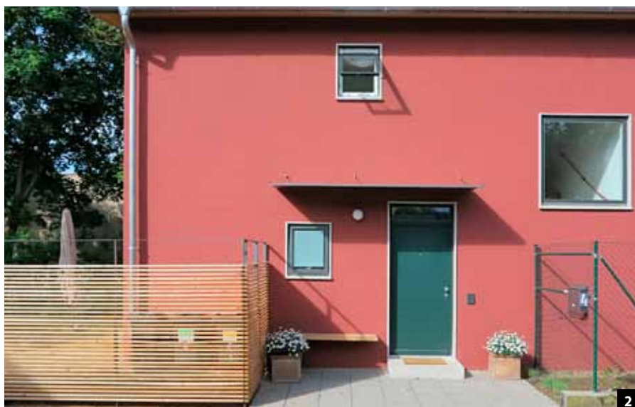
Abb. 2: Dieser Neubau wurde aus Leiblehm errichtet und mit einer Innendämmung gedämmt (vgl. Abb. 3).
