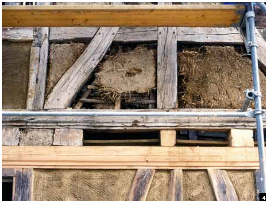
Abb. 4: Reparatur von Strohlehmgefachen: Intakte Teile werden erhalten und die Fehlstellen mit wieder aufbereitetem Material ergänzt.
