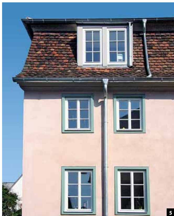
Abb. 5: Bei der Fachwerksanierung ermöglicht eine Innendämmung, die äußere Gestalt des Bauwerks zu erhalten. In diesem Haus wurde eine Zellulose-Einblasdämmung in eine Bekleidung aus Leichtlehm-Trockenbauplatten eingebracht (vgl. Abb. 7).
