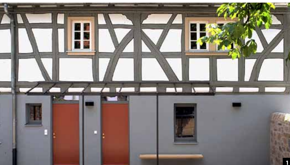
Abb. 1: Bei der Fachwerksanierung ist die homogene Ausmauerung der Gefache mit Leichtlehmsteinen Stand der Technik.
