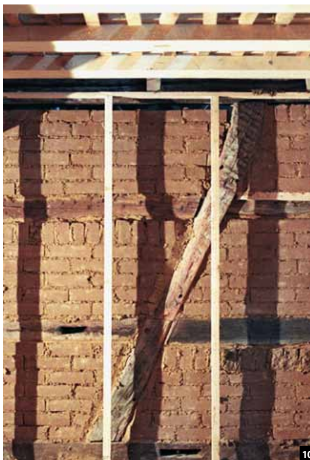
Abb. 10: Leichtlehmmauerwerk lässt sich universell in Außen- und Innenwänden einsetzen. Die Lattenkonstruktion ist für die Innendämmung mit Lehmplatten vorbereitet.
